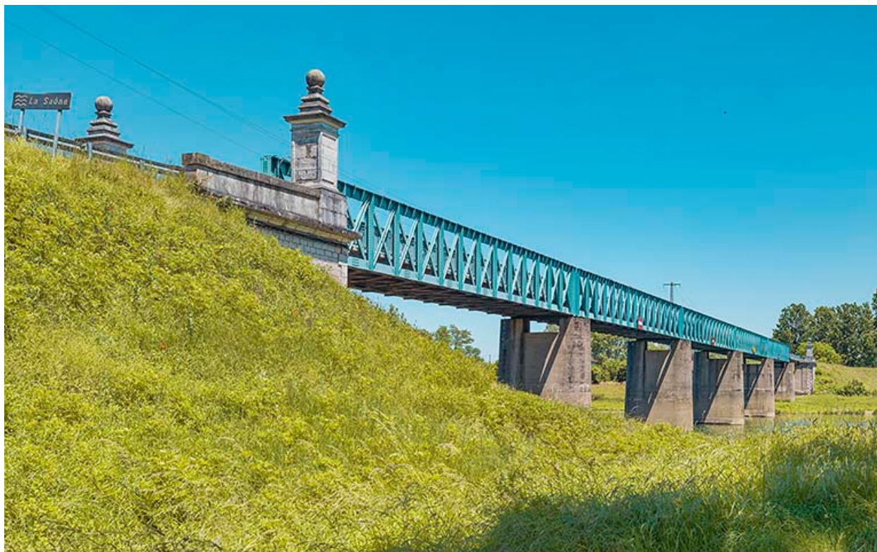
Vue d'ensemble du pont.
