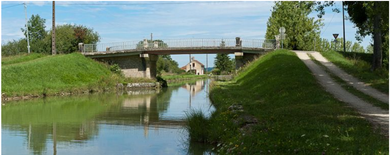
Vue du pont depuis l'aval.
