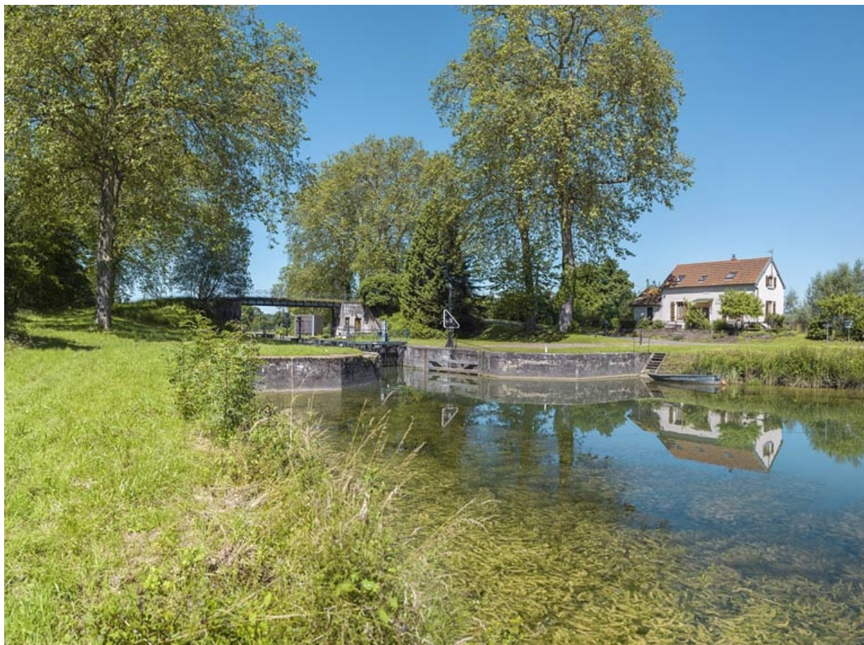
Maison éclésièrè et site de l'écluse 18 dite d'Heuilley (21).
