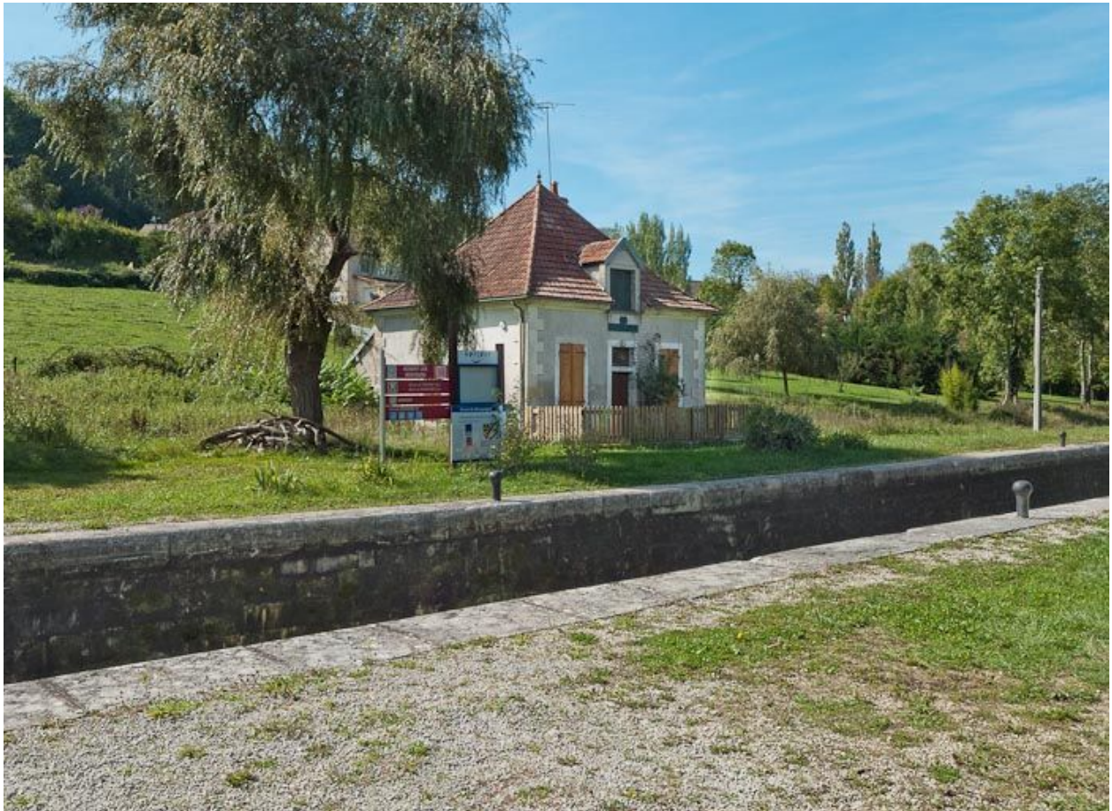
Vue d'ensemble du site d'écluse.
