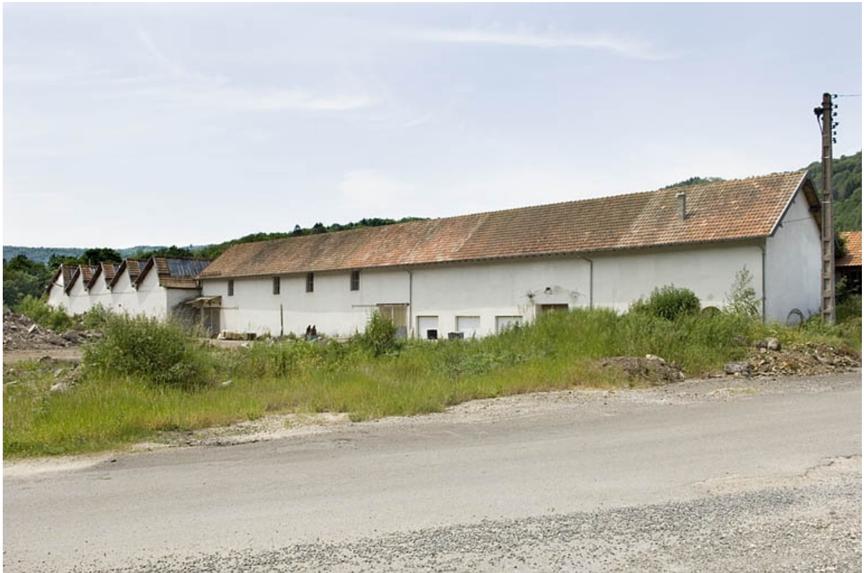
Atelier de fabrication (boulonnerie) depuis l'est.
