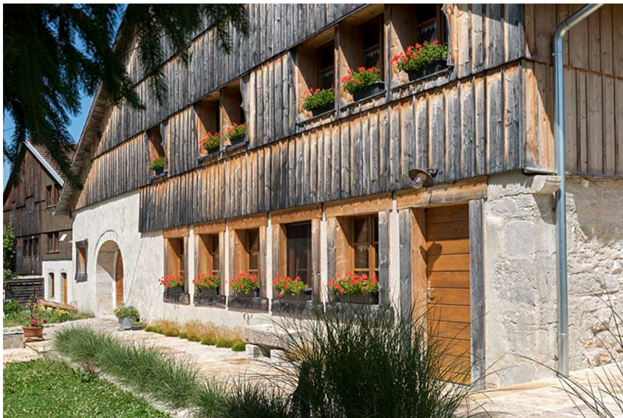
Façade antérieure, vue en enfilade.
