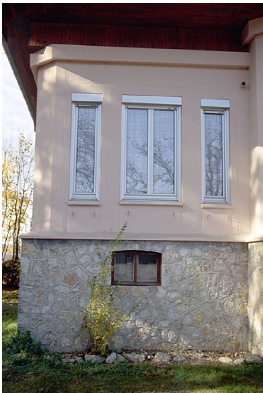
Façade antérieure : fenêtres du renforcement à gauche.
