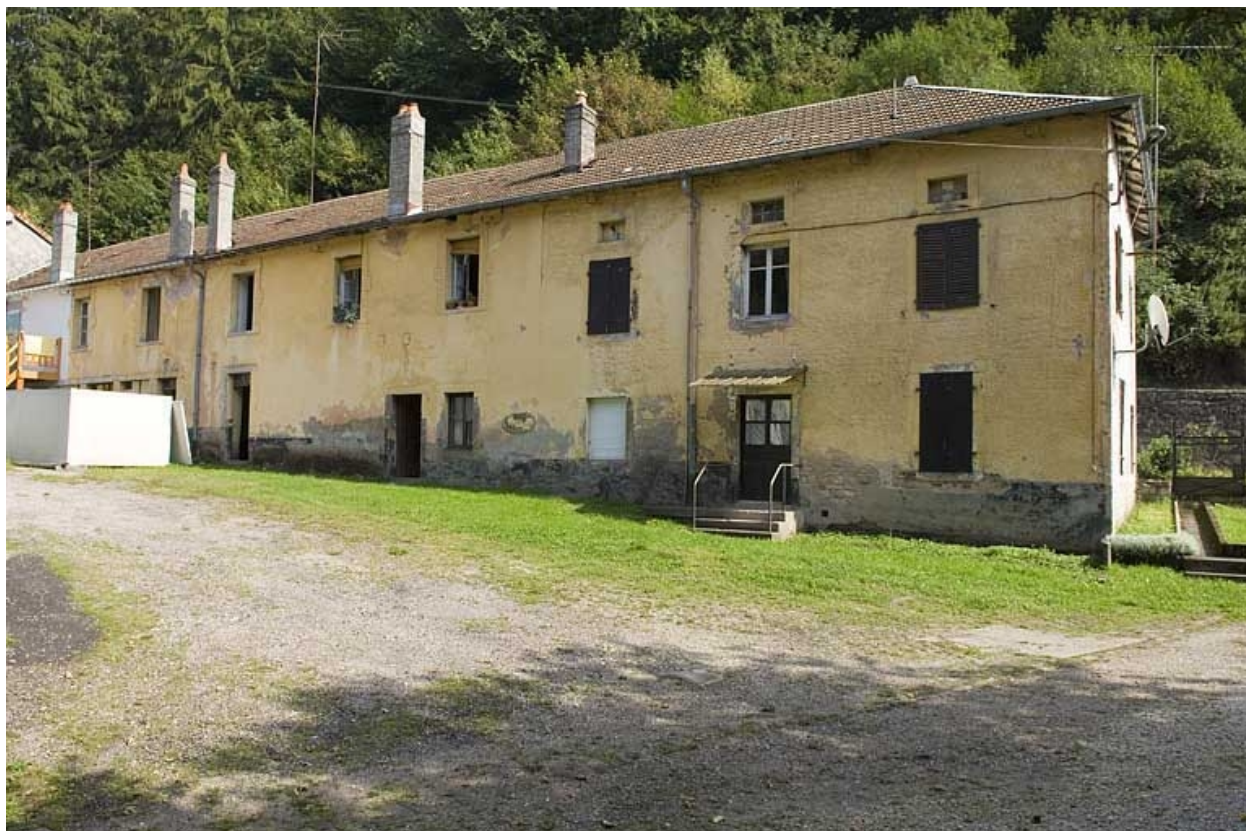
Façade occidentale des logements ouvriers.
