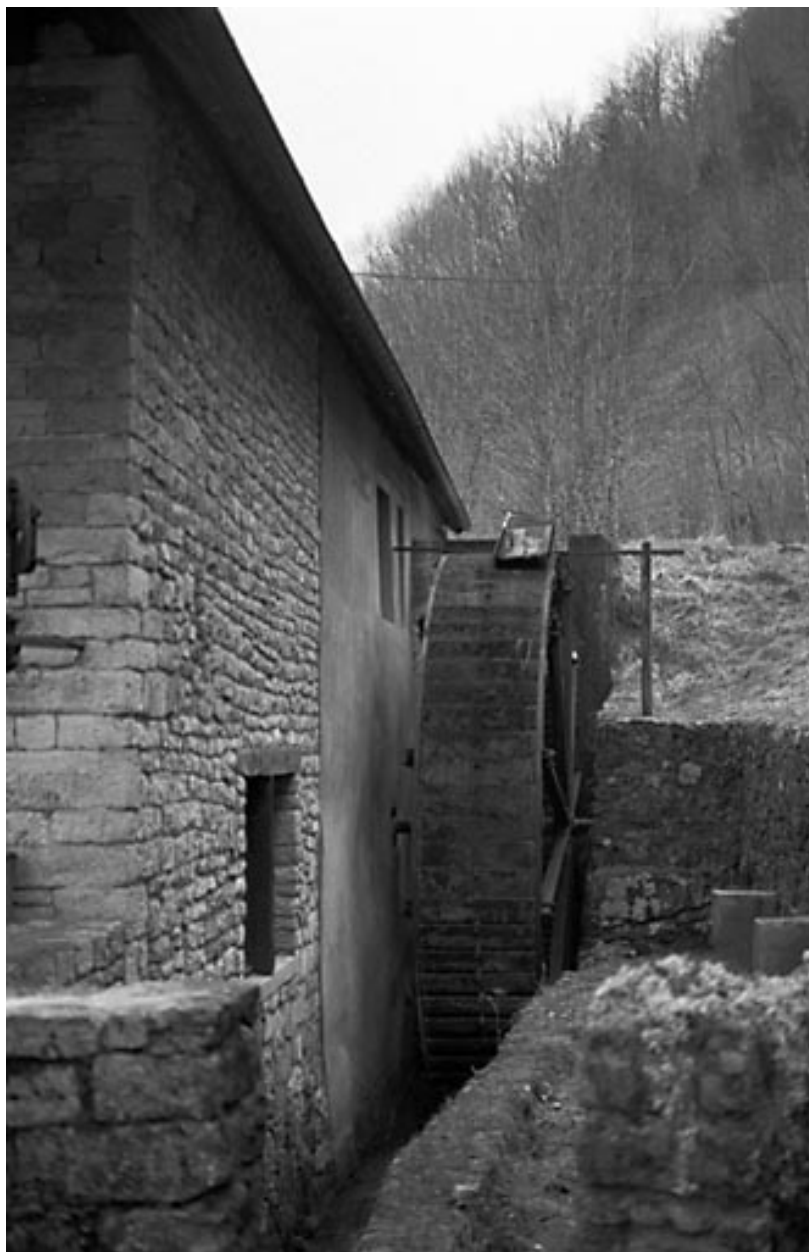
Façade latérale droite : la roue hydraulique verticale en 1980.
