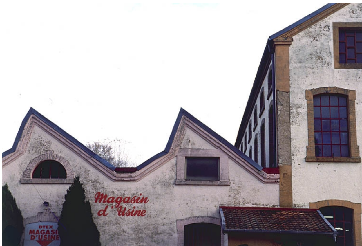
Détail des pignons.
