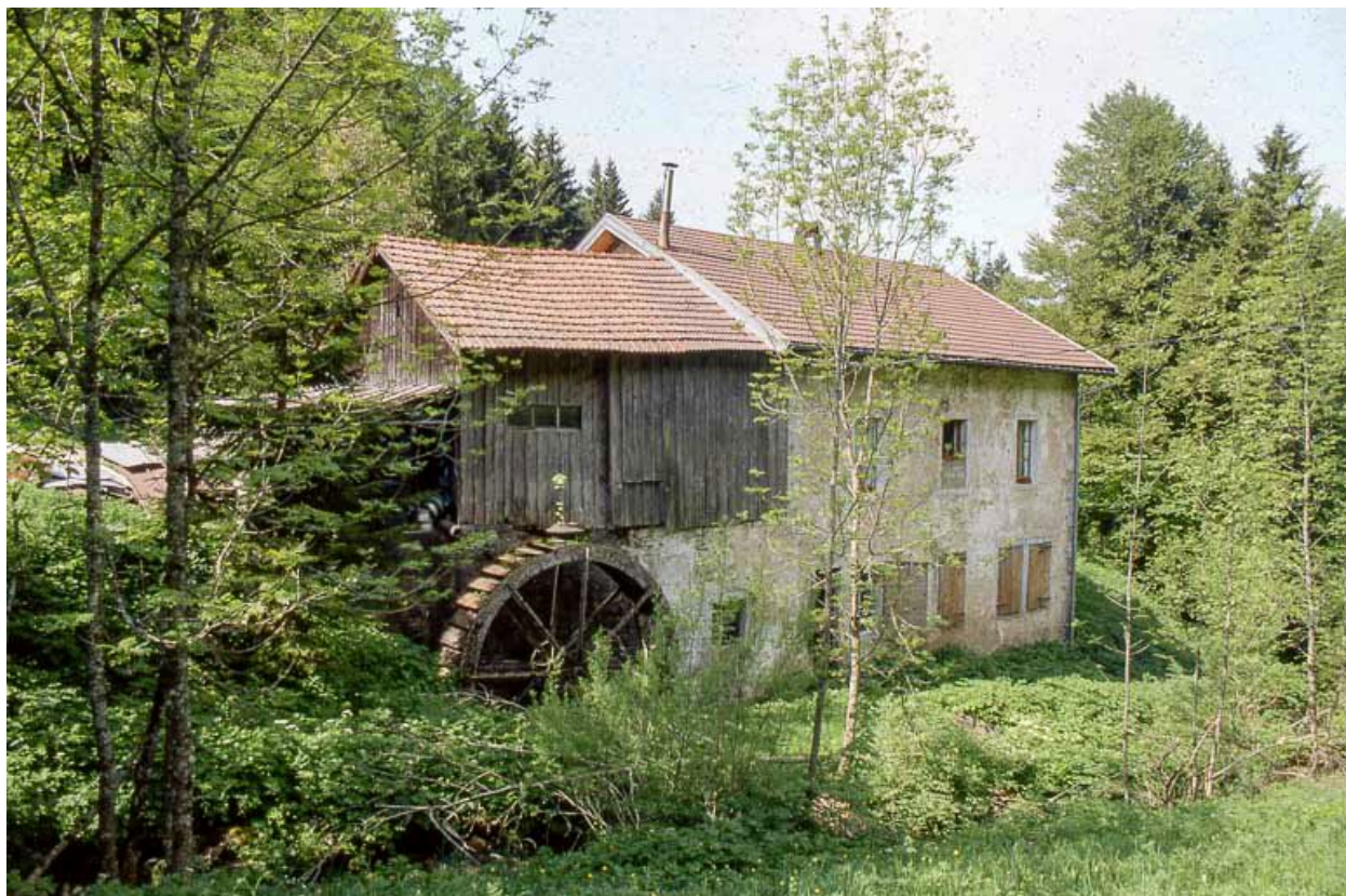
Façade postérieure et roue.
