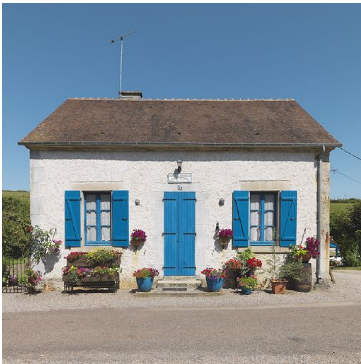
Vue de face de la maison éclusière.
