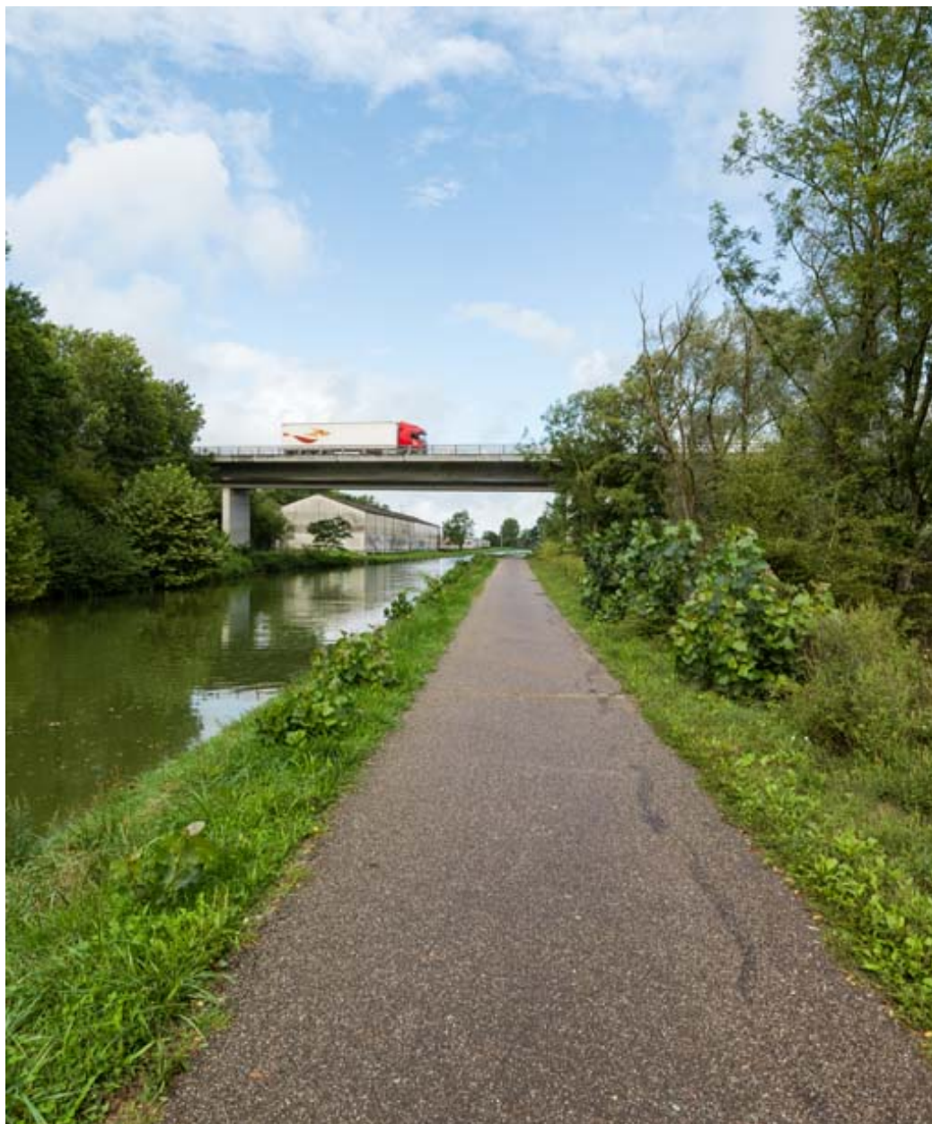
Vue d'ensemble du pont.
