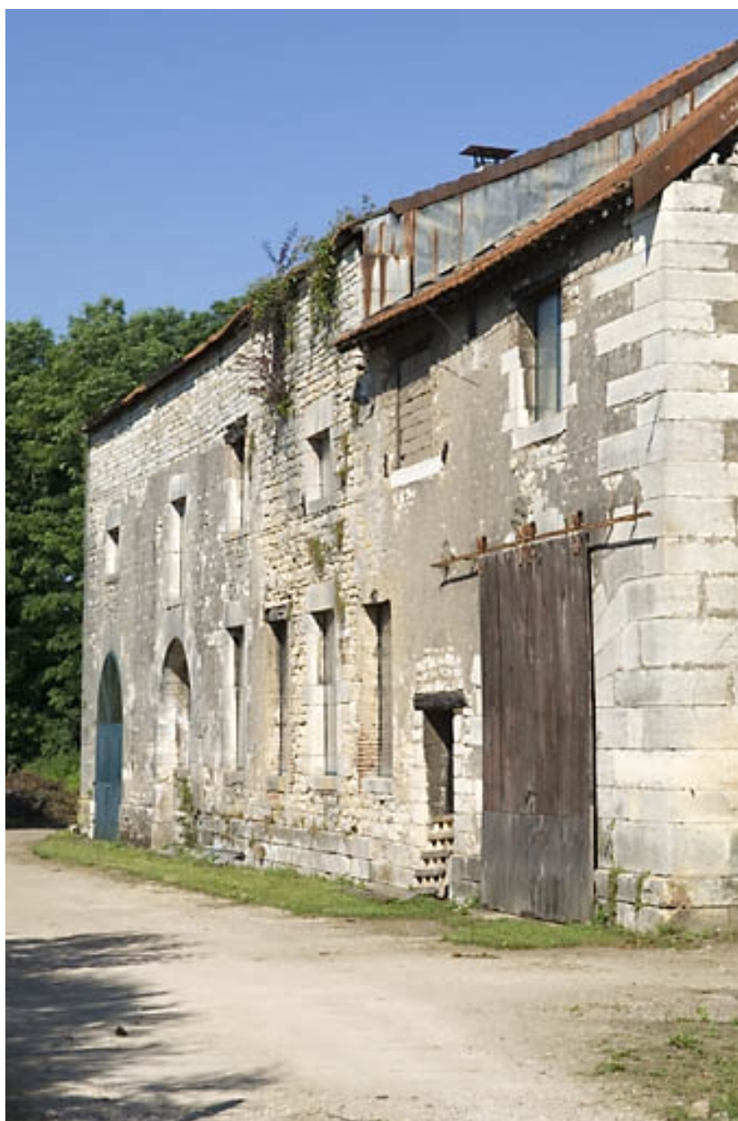
Bâtiment du haut fourneau ouest.
