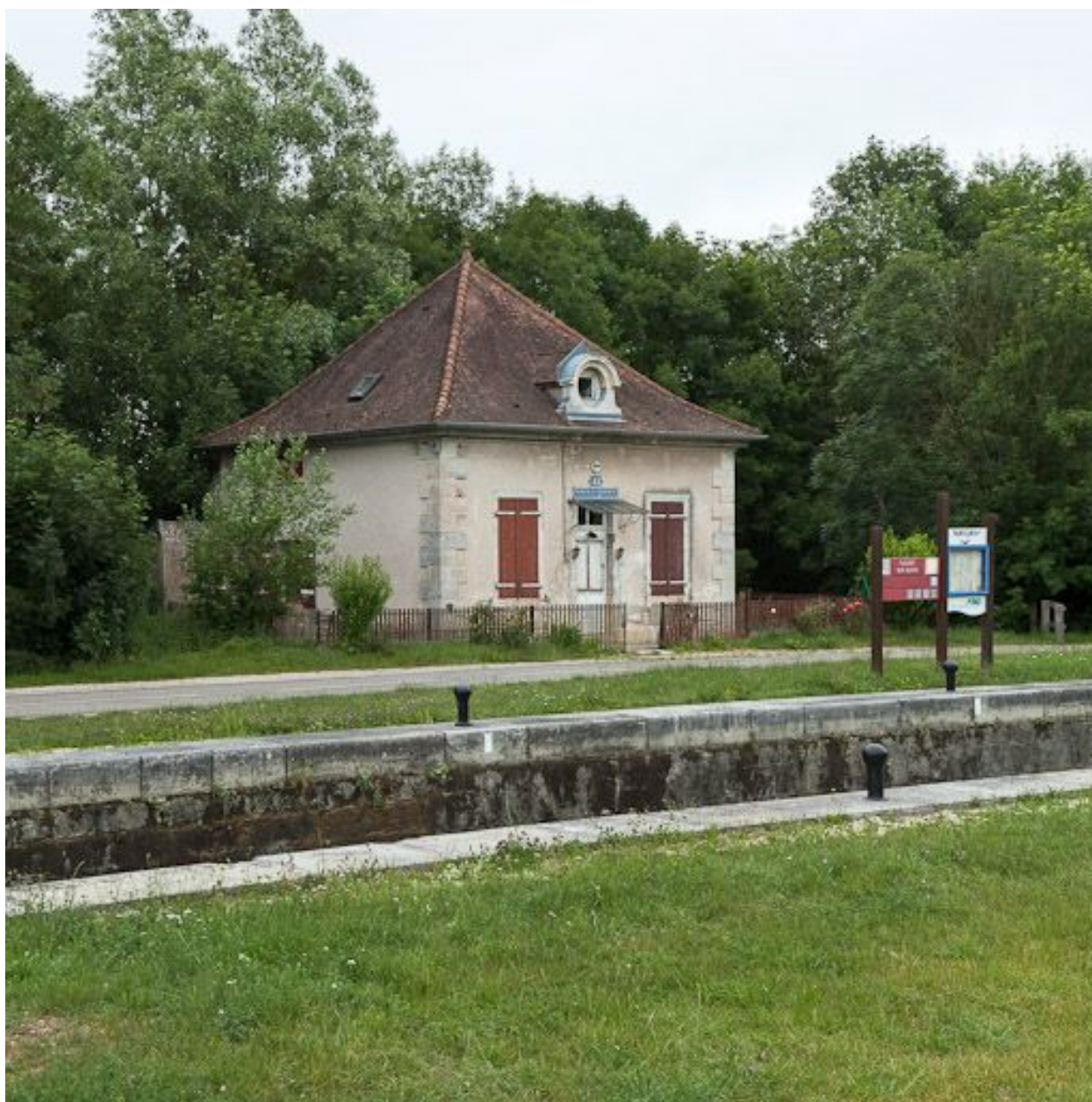
Vue du site d'écluse.
