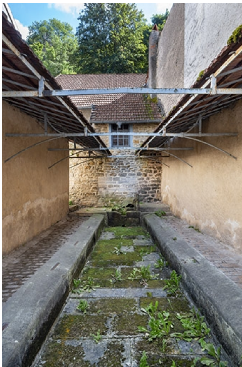
L'intérieur de la fontaine-lavoir.
