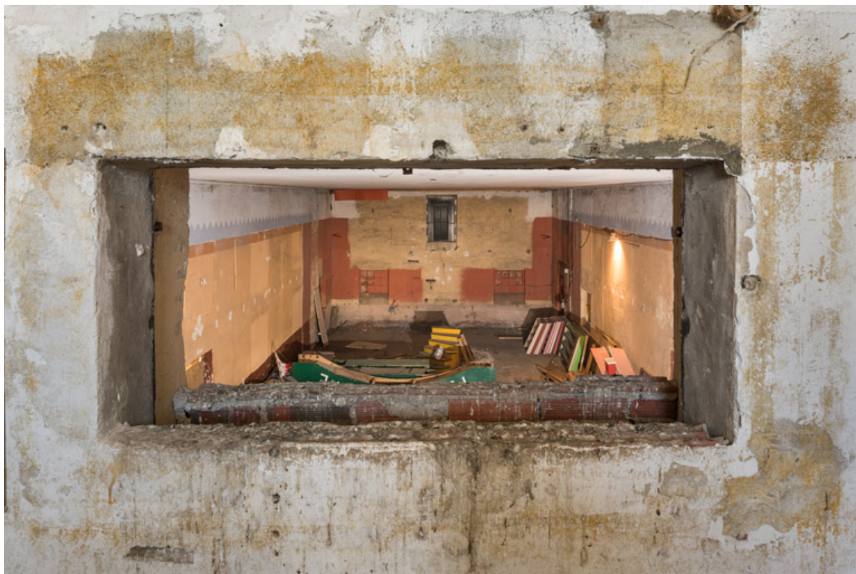
Salle, vue de la cabine du projectionniste.
