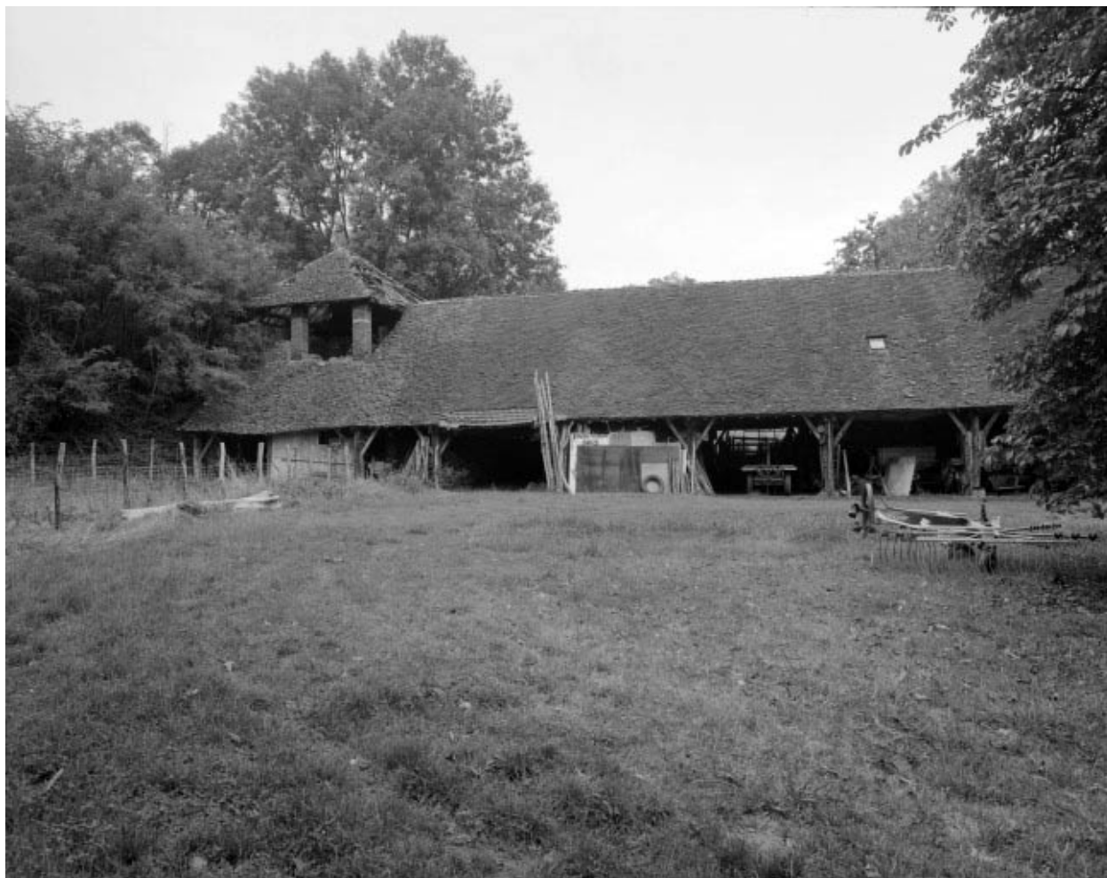
Four industriel et pièce de séchage.
