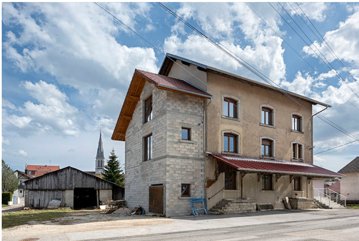
Façades antérieure et latérale gauche.
