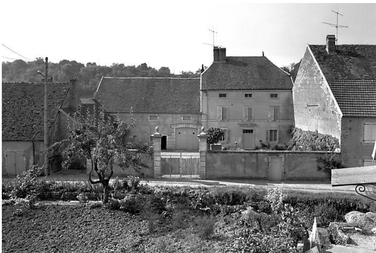
Ferme située 34 rue du Canal.
