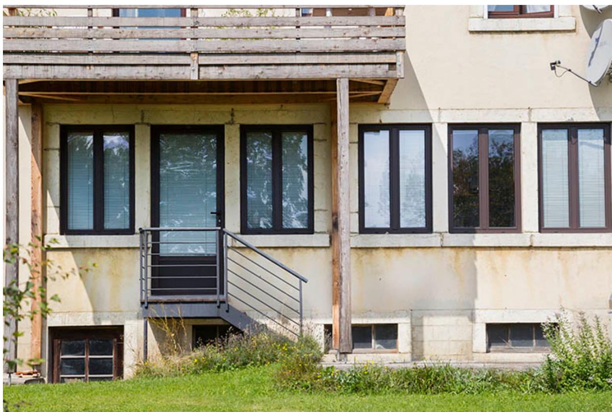
Façade postérieure : fenêtres de l'atelier.
