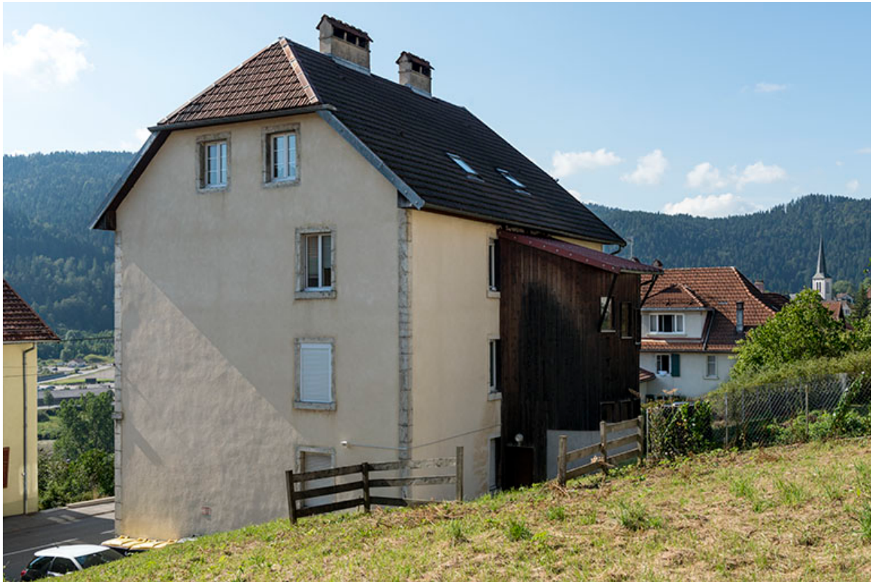
Façades postérieure et latérale droite.
