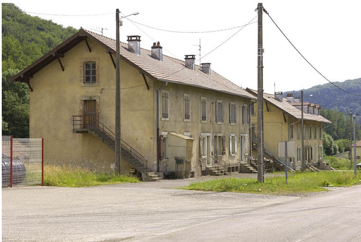
Vue d'ensemble des logements ouvriers.
