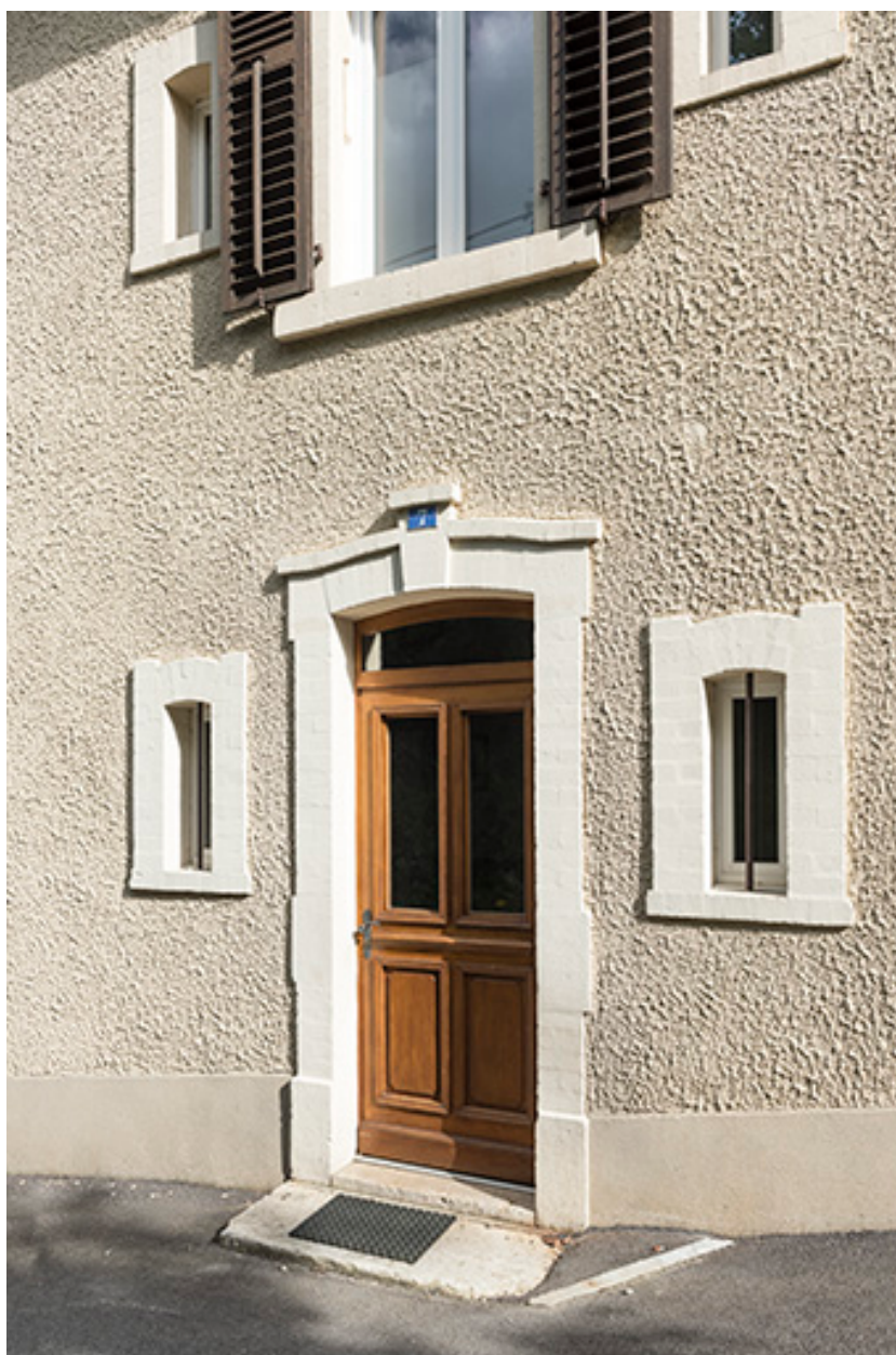
Façade antérieure : entrée.
