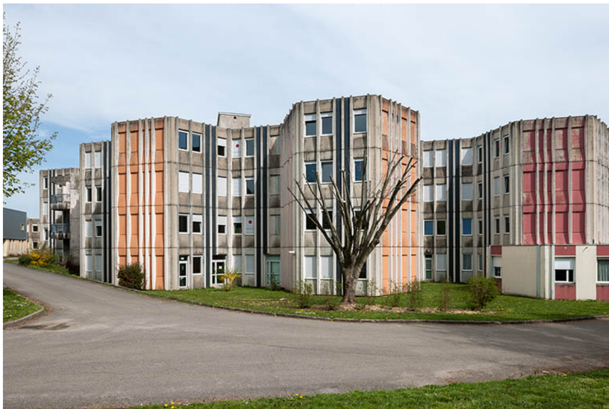
Les façades ouest de l'internat.
