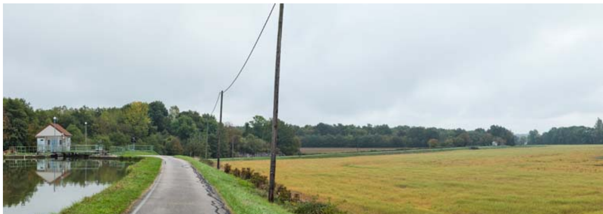
Vue d'ensemble du site d'écluse.
