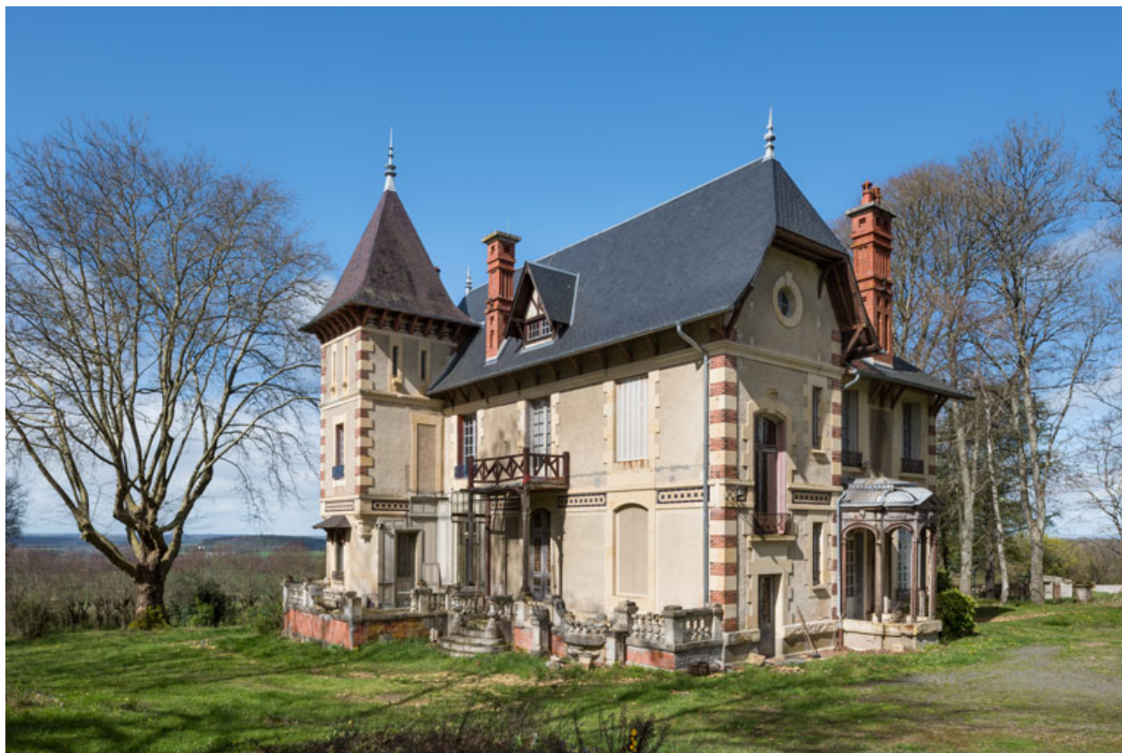
Façades sud et est.
