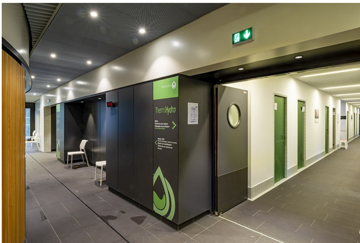
Couloir des cabines d'hydrobain et d'aérobain.
