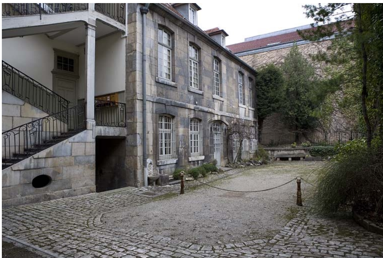
Vue d'ensemble de l'aile gauche sur cour.
