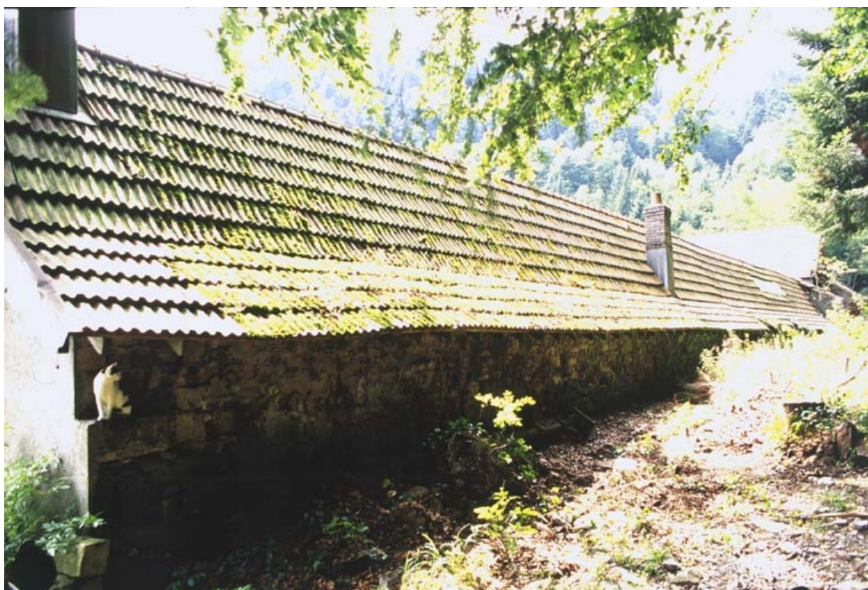
Versant nord (brisé) d'un shed.
