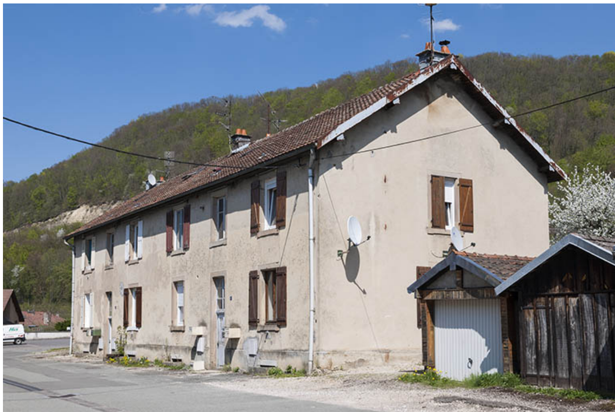
Habitation (6-8 logements) vue de trois quarts.
