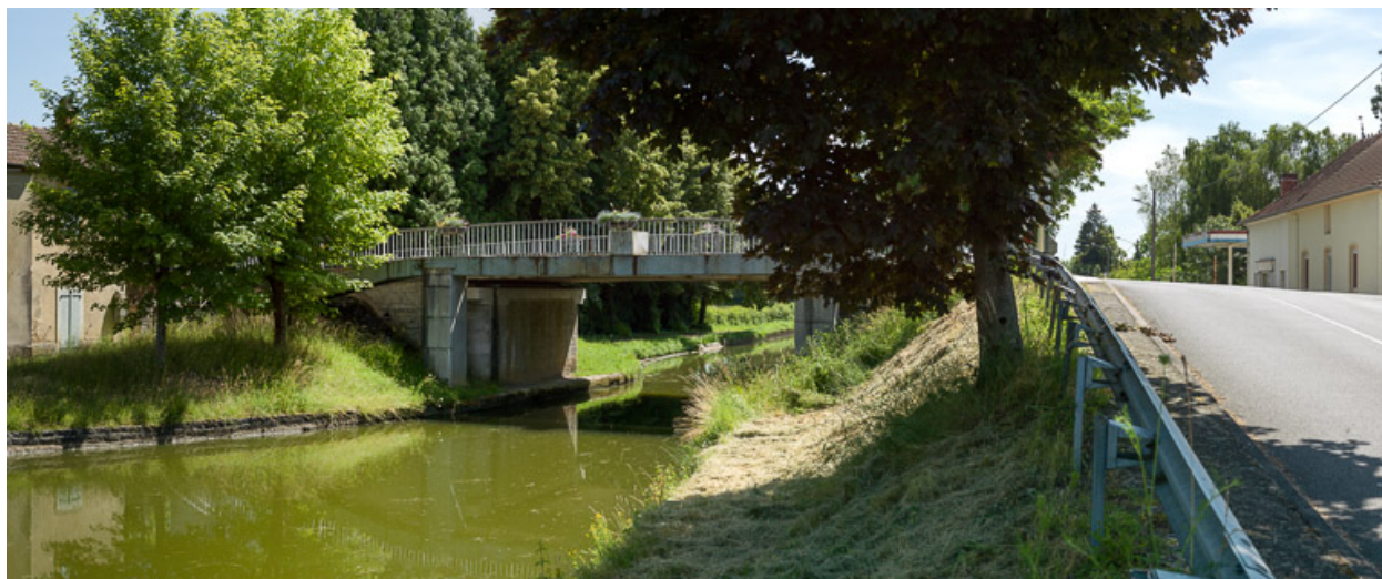
Vue d'ensemble, prise d'amont.
