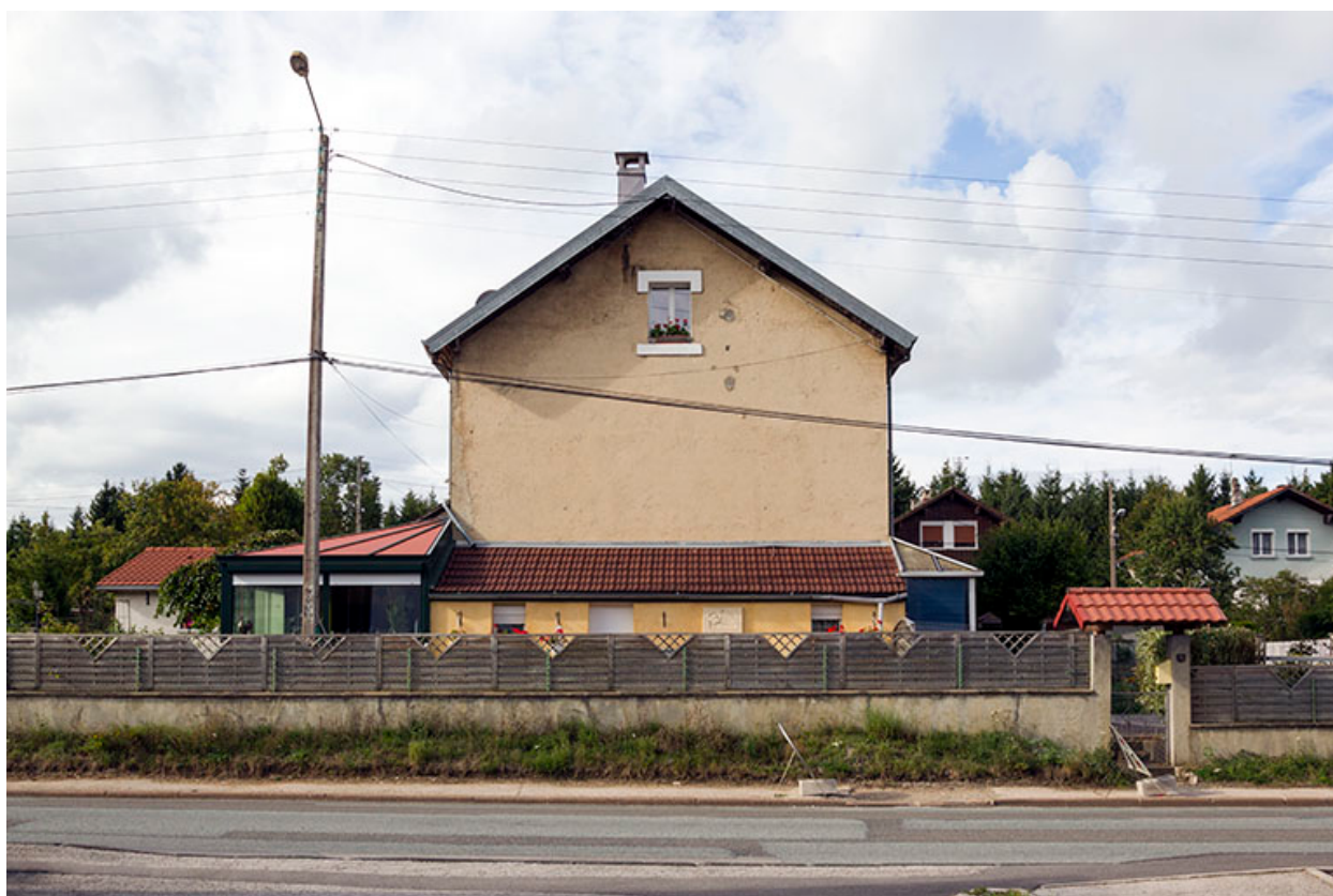
Immeuble au n° 9 : façade latérale sud.
