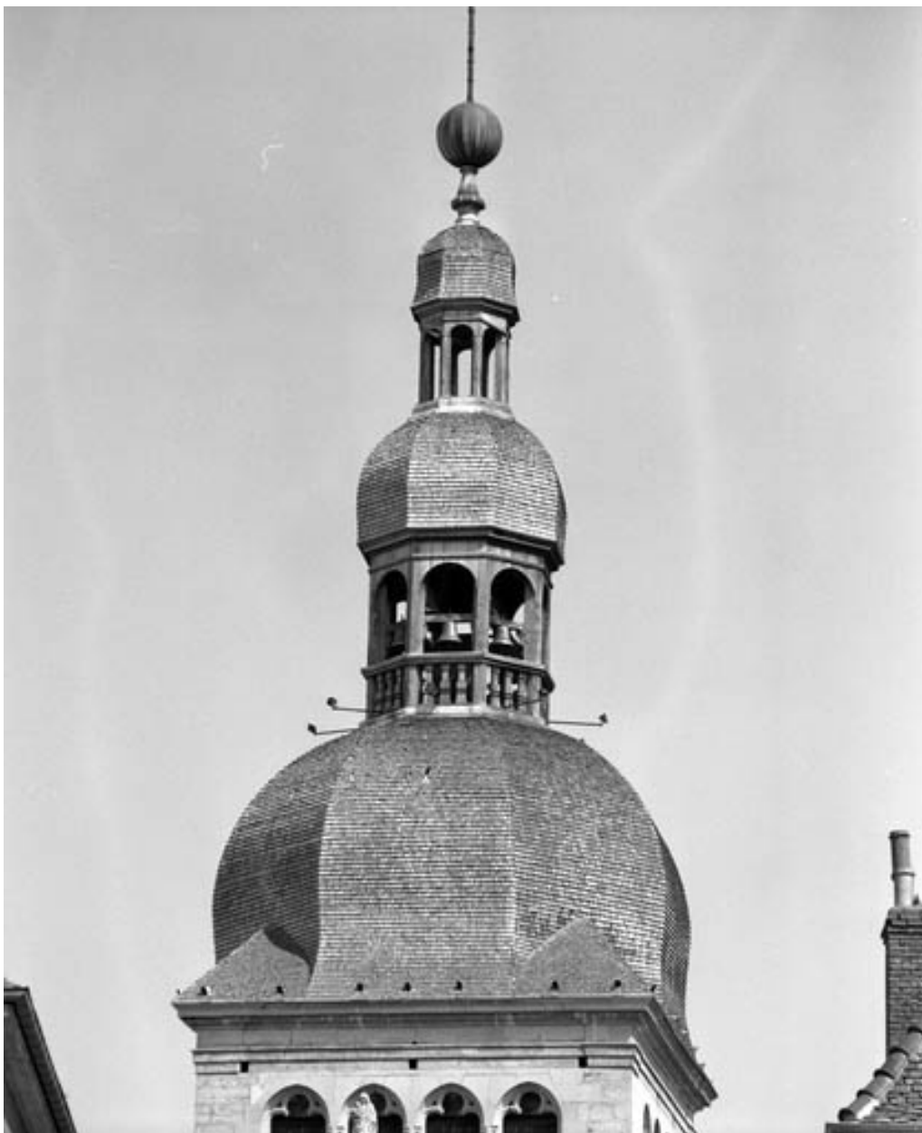
Tour-clocher : détail du bulbe et du lanternon.
