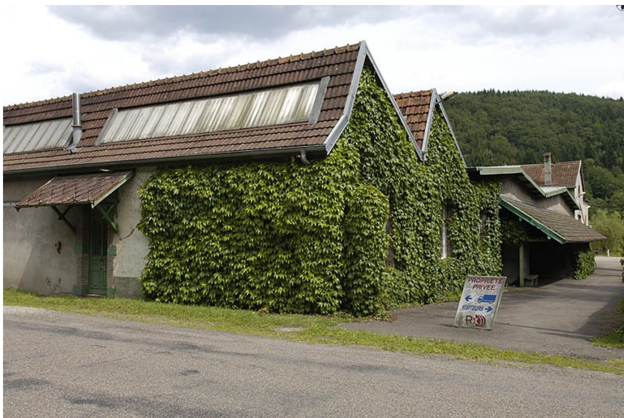
Ancienne entrée de l'usine.
