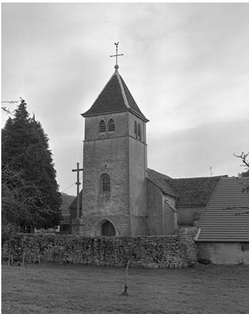
Extérieur : façade antérieure.
