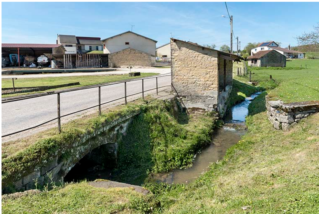
Vue générale du lavoir, Grande rue.
