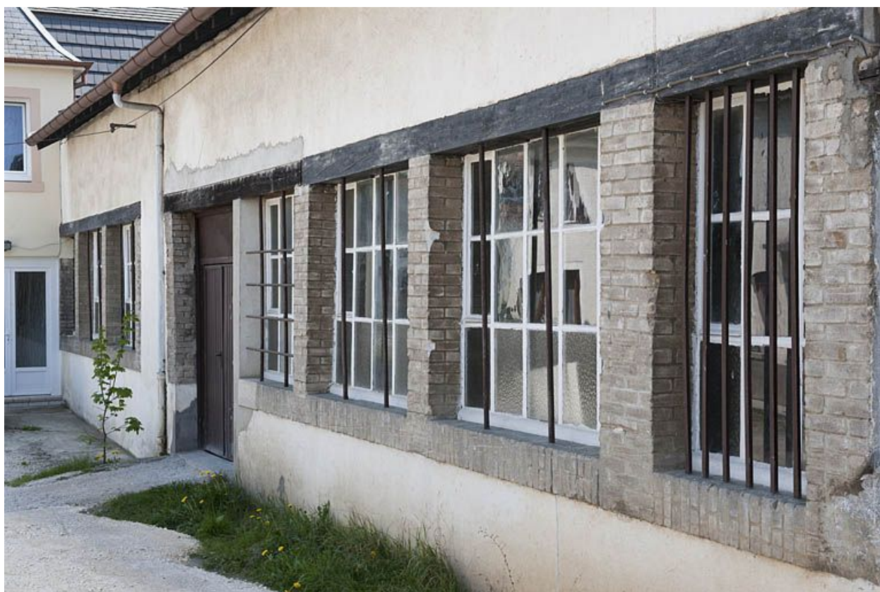
Mur nord de l'atelier de fabrication.
