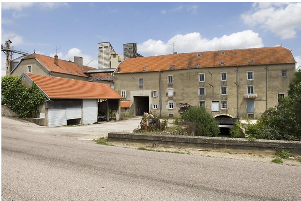
Vue d'ensemble depuis la route, à l'ouest.
