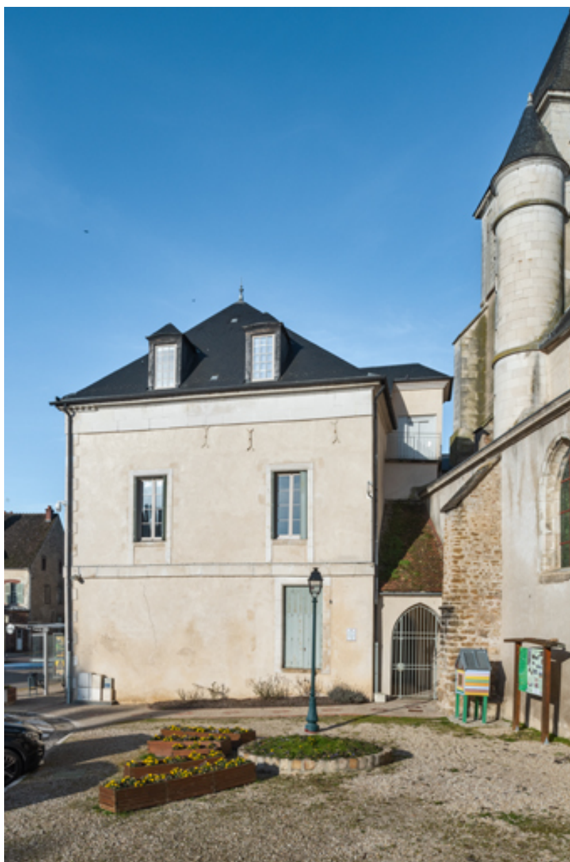
Façade latérale droite.
