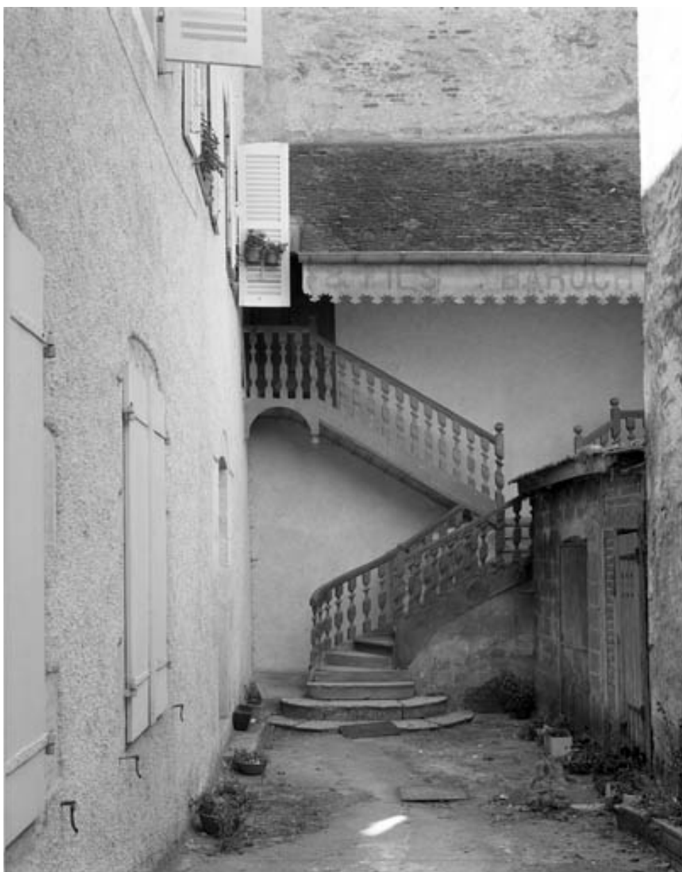
Détail de l'escalier extérieur : de face.
