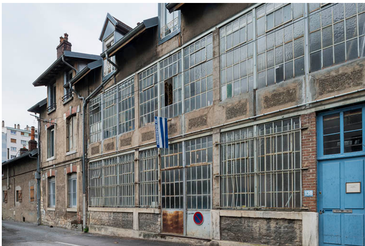
Façades d'ateliers ruelle de la Mouillère.
