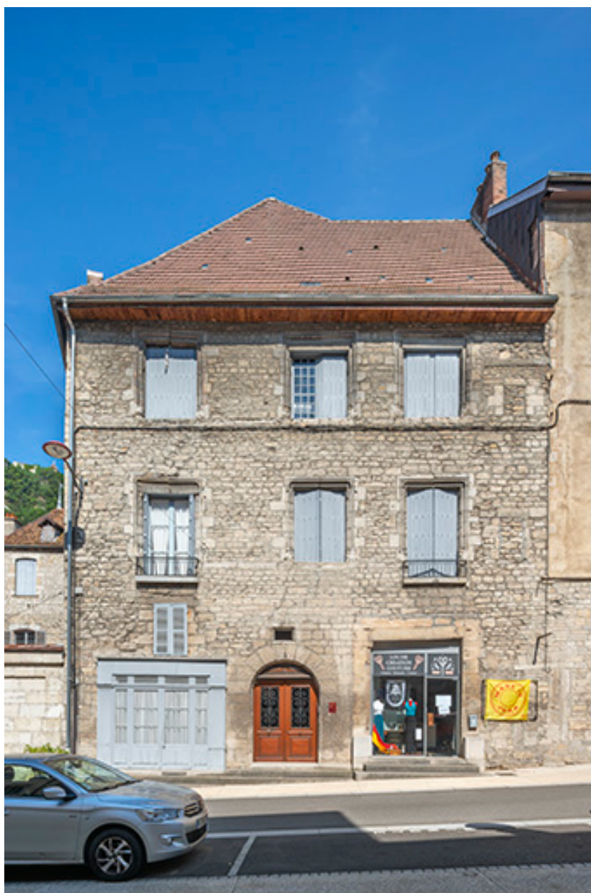
Bâtiment sud. Vue de face.
