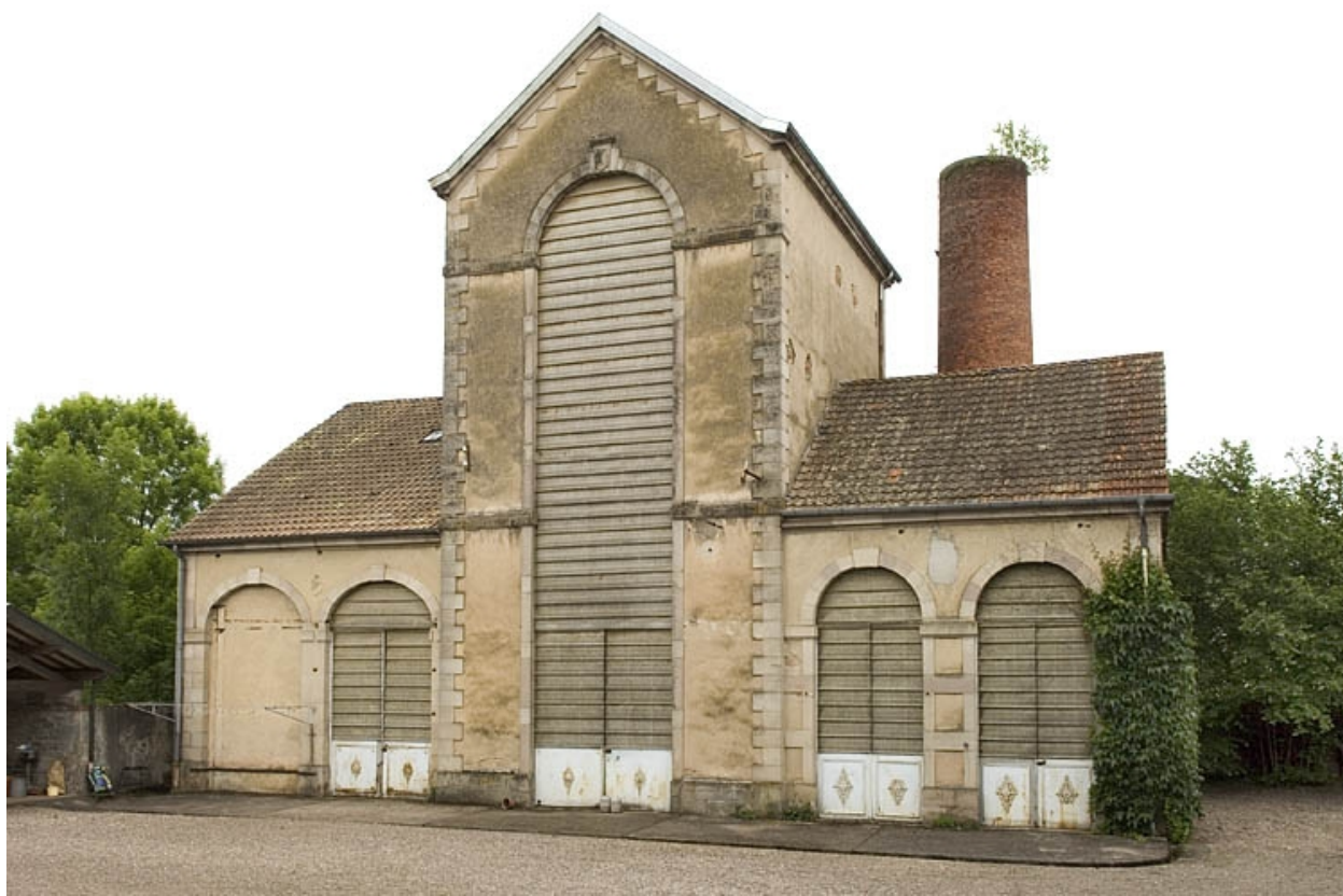
Bâtiment de rectification vu de face.
