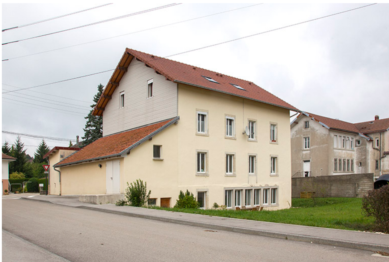
Façades postérieure et latérale gauche.
