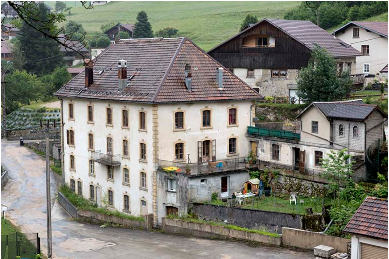
Immeuble et dépendance, depuis le nord-ouest.
