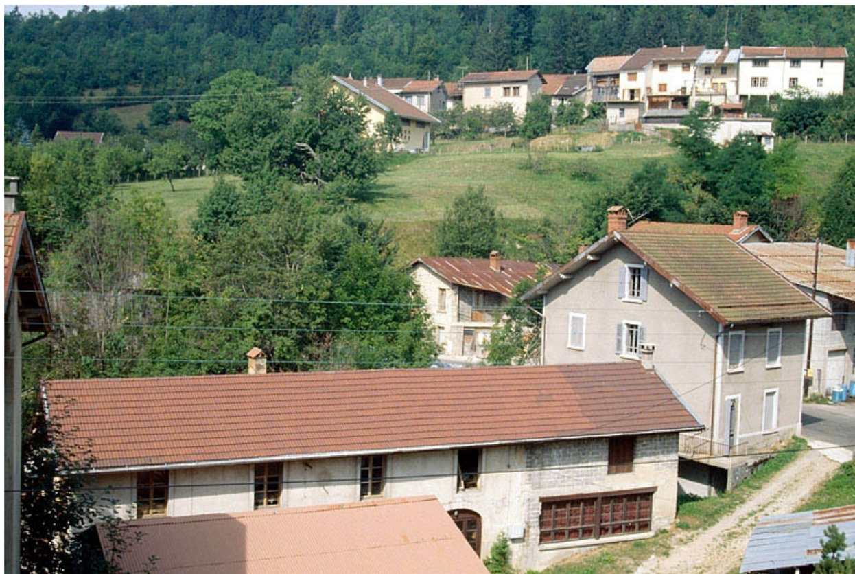
Ateliers de fabrication et logement.
