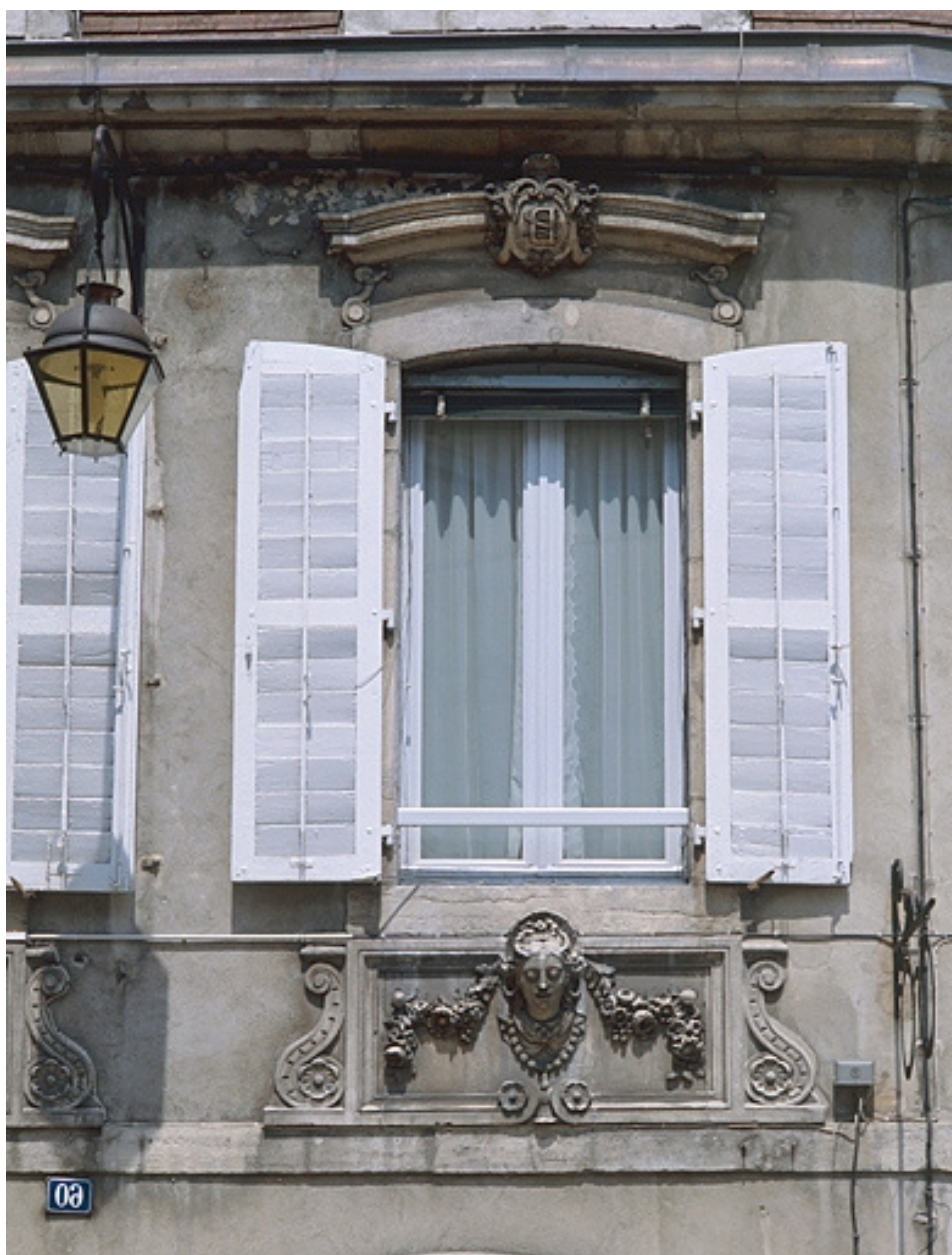
Fenêtre centrale de la façade antérieure.
