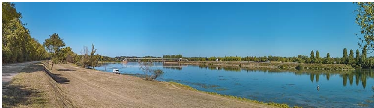
Les perrés et le barrage d'Ormes.
