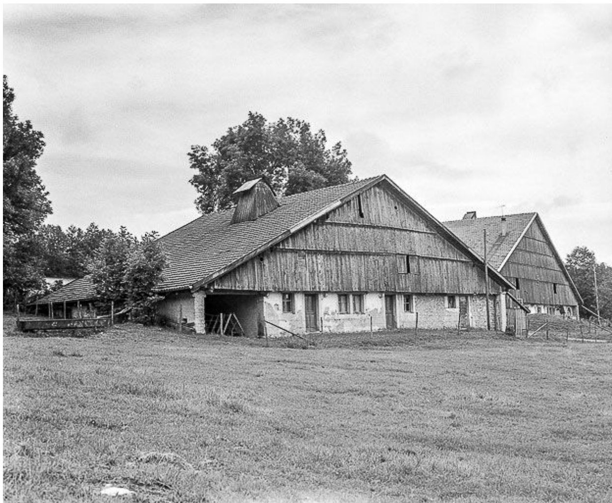
Fermes 1 et 2 : façades antérieures.
